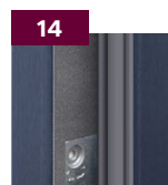
14 Uszczelka pęczniąca (drzwi PPOŻ)
