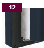
12 Uszczelka samoopadająca (w opcji dymoszczelności)
